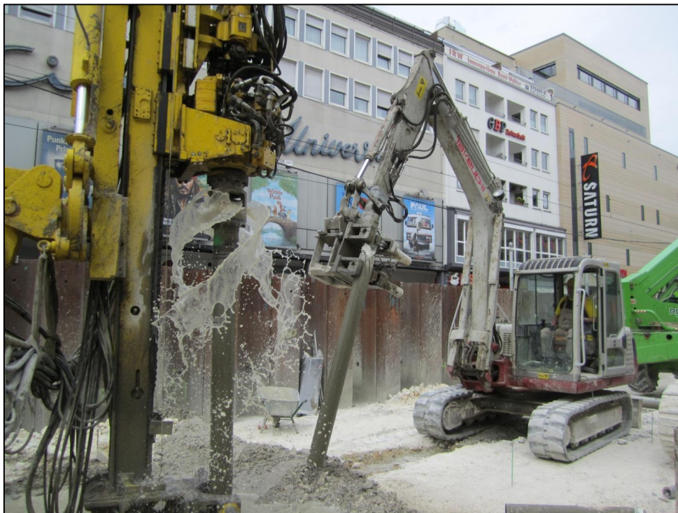
Abbildung 3: GEWI Bohrgerät & Hilfsbagger am Europaplatz (17.05.2011)
