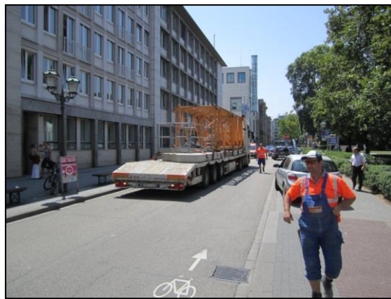
Abbildung 18: Antransport des ersten Turmstückes und Sicherung der Strasse durch die Arbeiter (Lammstrasse Höhe Ettlinger Tor)
