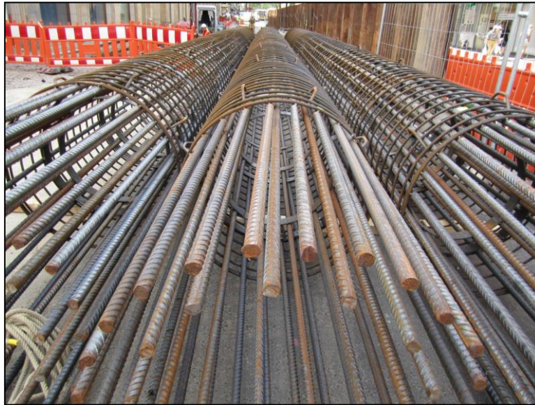
Abbildung 8: Bewehrungskörbe für die BPW Lammstrasse
