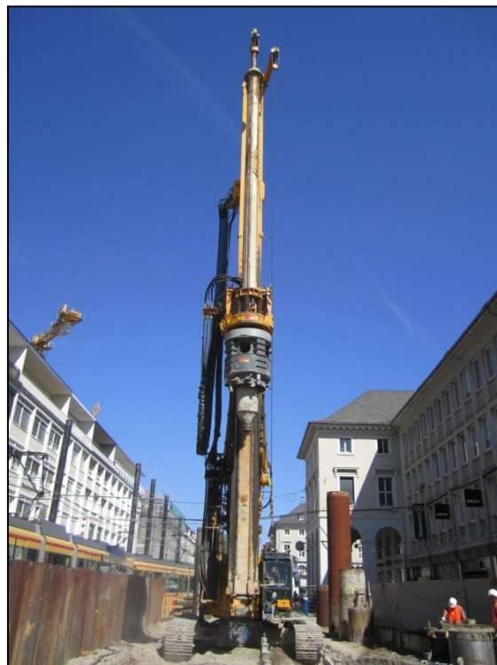
Abbildung 7: Bauer BG36H Drehbohrgerät
