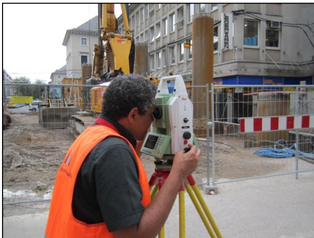
Abbildung 13: Einmessen durch die Geodäten mithilfe eines Theodoliten
