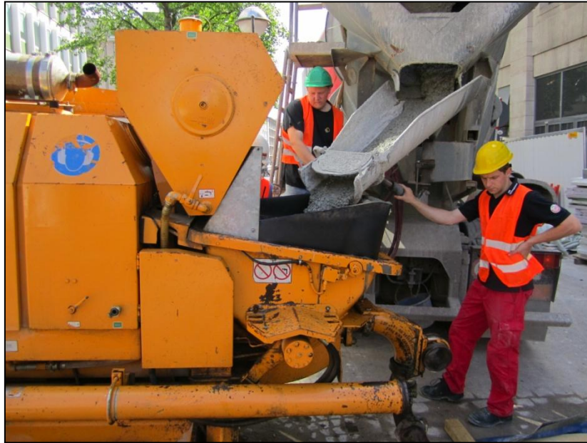
Abbildung 10: Befüllen der Betonpumpe
