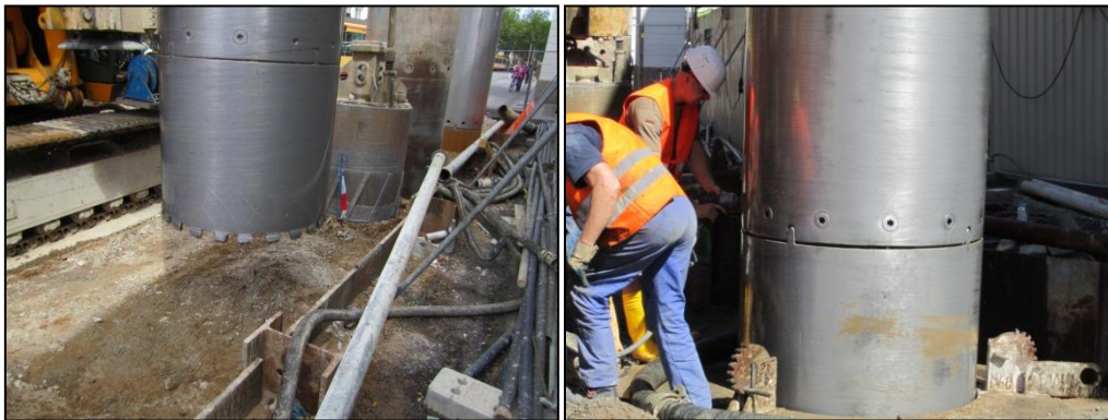
Abbildung 12: (links) Anfängerrohr / (rechts) Einbringen der "Nüsse" mithilfe eines Schlagbohrers
