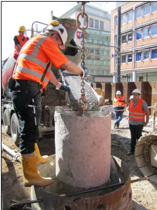
Abbildung 11: Befüllen des Bohrfahles
