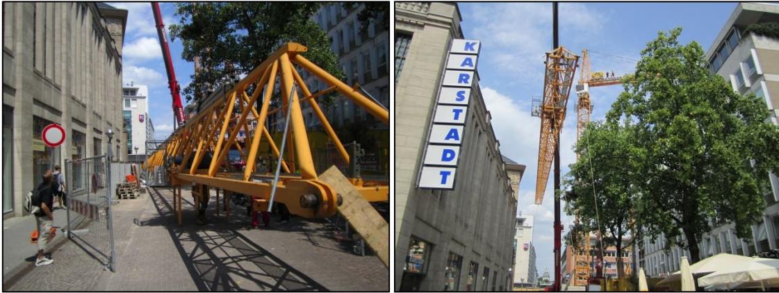
Abbildung 18: Zusammenbau und Einheben des Auslegers in der Lammstrasse
