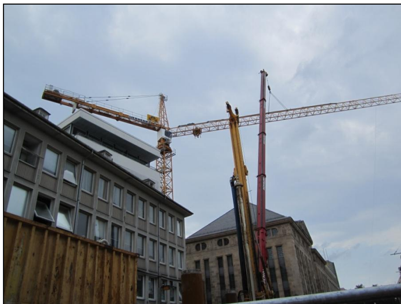
Abbildung 19: Festmachen des Auslegers aus Sicht der Kaiserstrasse (zu sehen ist einer der beiden Autokrane)
