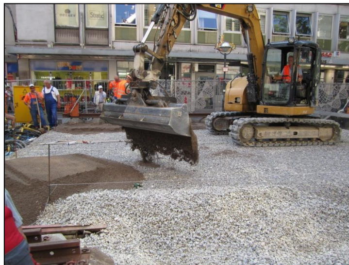
Abbildung 17: Aufbringung von gebrochenem Kies zur Ebenenherstellung
