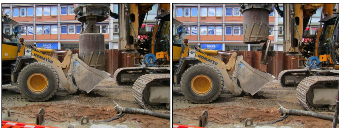
Abbildung 9: Entleeren des Bohreimers
