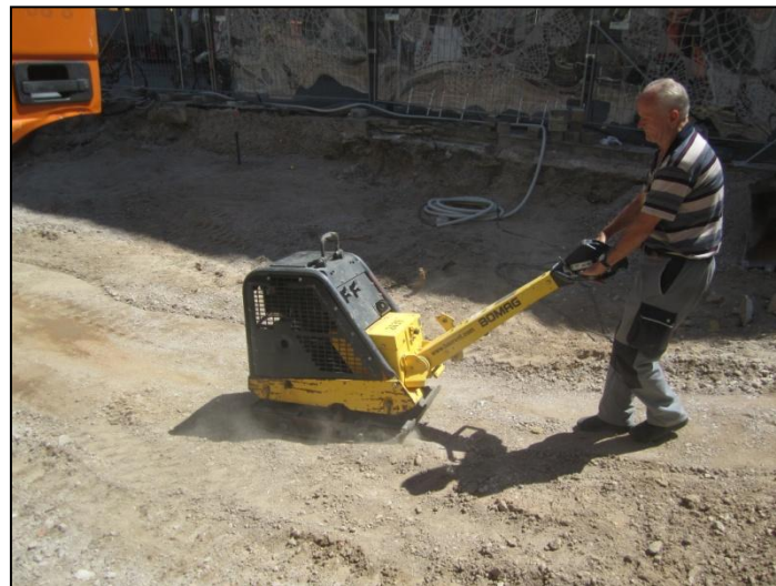
Abbildung 15: Rüttelplatte zum Verdichten des Bodens
