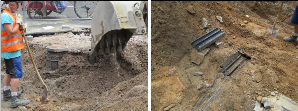
Abbildung 14: Bagger-Arbeiten am Wasserhydranten / Angetroffenes "leeres" Telekomrohr
